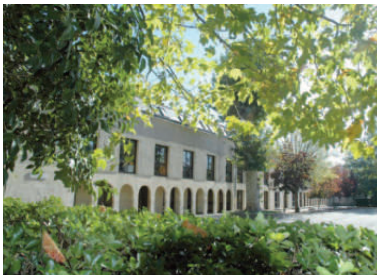
Le bâtiment du Lycée
